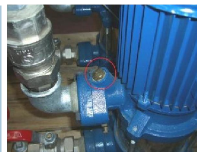
Obr. 7: Montáž snímača na odvzdušňovací otvor čerpadla
