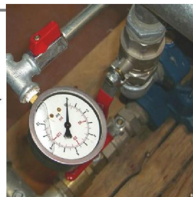
Obr. 6: Výmena TS za manometer
