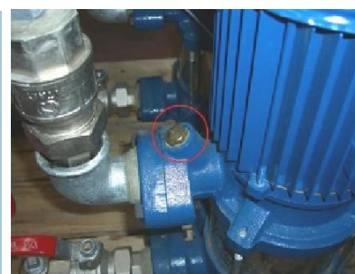
Obr. 7: Montáž snímača na odvzdušňovací otvor čerpadla
